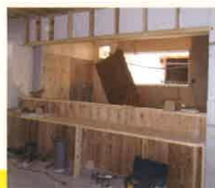
2013年 キッチン改装工事の様子
